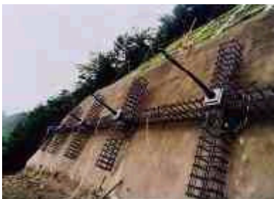
広域営農団地農道整備工事
