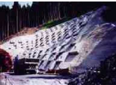
関西電力紀北変電所
