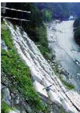
生活道路改良整備工事
