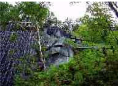
バサラン岬 復旧治水工事
